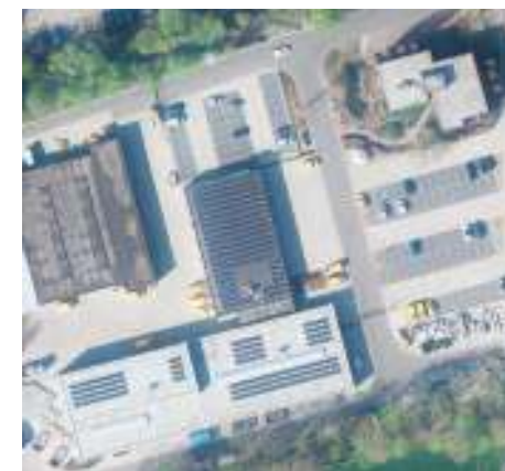
De zonnepanelen op de daken van de loodsen van de gemeentewerf. Foto: Gemeente Kerkrade
